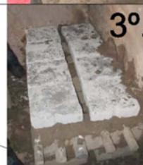
4. CAJAS DE LA COCINA: CAJA DE CANDELA Y CAJA DE HUMOS REALIZADAS CON ADOBE, DE UNA ALTURA DE UNOS 30 CM. ABERTURAS: ENROJE PARA LA ENTRADA DE LEÑA, CONEXIÓN PARA SALIDA DE HUMO, Y HUECO PARA LIMPIEZA DEL HOLLÍN
