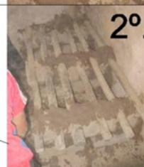
3. TABLERO: SOBRE LOS MADEROS SE COLOCAN ADOBE EN HORIZONTAL FORMANDO EL MESÓN, RECIBIÉNDOLOS CON BARRO Y RELLENANDO LAS JUNTAS. FINALMENTE SE RECUBRE TODA LA SUPERFICIE CON UNA CAPA DE BARRO DE 3cm.
