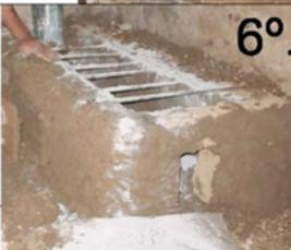
7. SOBRE LOS FIERROS SE ASIENTA UNA CHAPA CON AGUJEROS PARA COLOCAR LAS OLLAS. LA CHAPA SE ASIENTA CON BARRO SOBRE LOS MURETES, Y SE CUBRE POR ENCIMA CON UNA CAPA DE BARRO EN EL CONTORNO.
