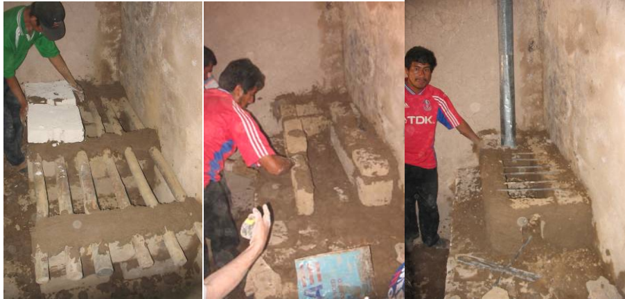
Fig. 4: Proceso de construcción.
