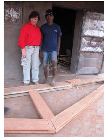
Fig. 8: La cercha terminada
