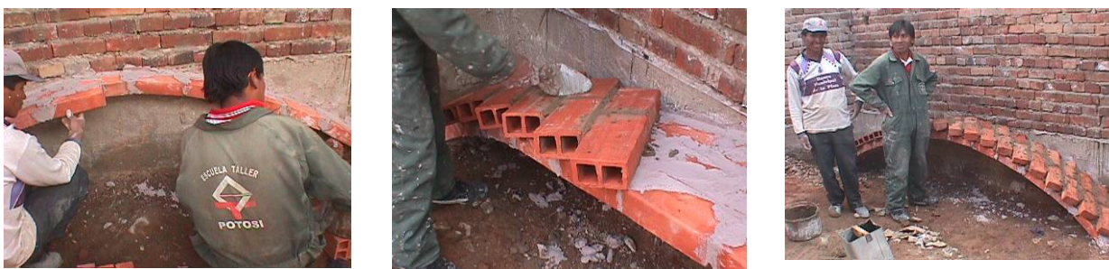
Fig. 11: Construcción de la maqueta a escala, ASFCyL.
