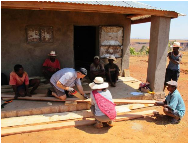
Fig. 7: Taller de construcción de la cercha
